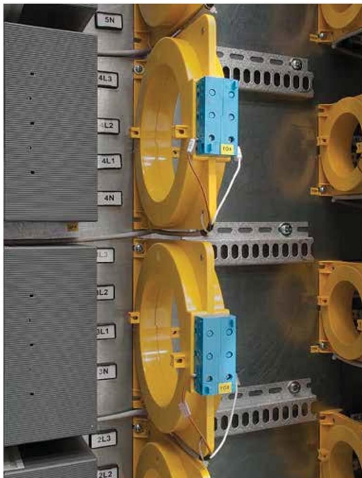
La gamma di relè differenziali Delta modulari e da incasso, in abbinamento ai trasformatori toroidali Del e Del A (apribili), ha come obiettivo la protezione di persone e beni, assicurando nello stesso tempo la continuità di servizio degli impianti.
