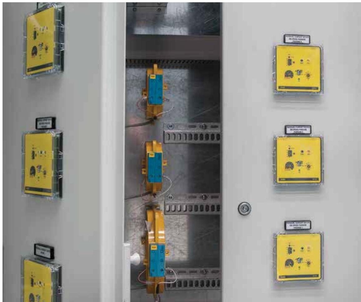
Una caratteristica importante della serie Delta è il controllo permanente del circuito di collegamento tra relè differenziale e toroide: al rilevamento di una qualsiasi anomalia del collegamento tra toroide e relè la protezione interviene automaticamente, senza dover aspettare il controllo periodico da effettuare con il pulsante di test.
